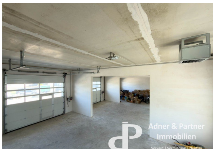
Blick vom Vorarbeiterbüro
